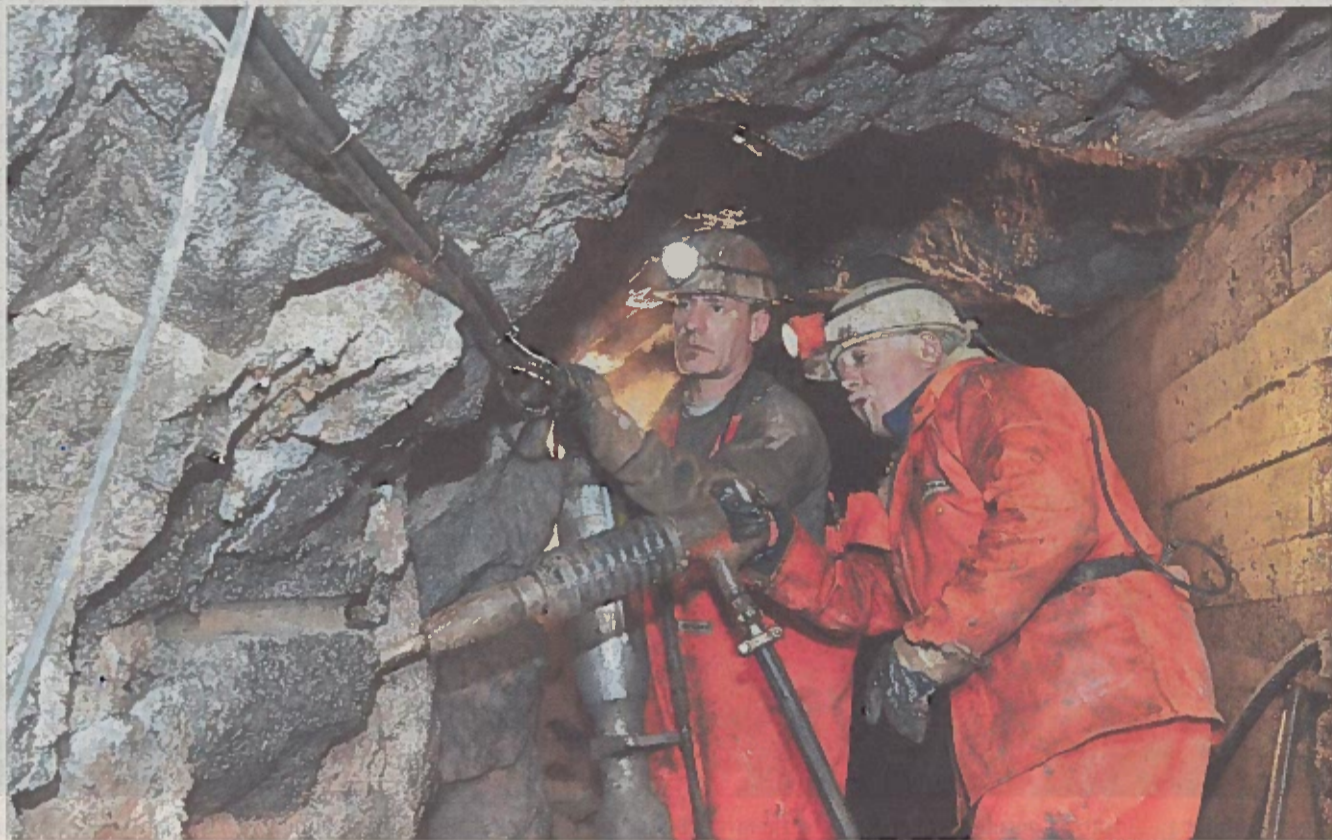
Herbert Schumann (re.) und Axel Hölbing, Mitarbeiter der Bergsicherung Freital, lösen im Tiefen-Bünau-Stollen in Zinnwald mit dem Presslufthammer Gestein, das sie vorher mit Bohrer und Spreizer gelockert haben. Gestern haben sie begonnen, 20 Tonnen Erz abzubauen. Diese Woche sollen die Arbeiten fertig werden.
